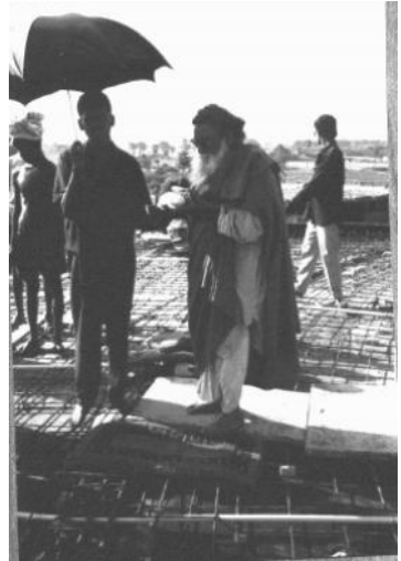
* A droite : le 6 décembre dernier, Yogiji assiste à la puja au premier étage : on va 'couler' le béton tout autour de la dalle de cet étage. C'est sur ce béton que reposera le grand dôme.
