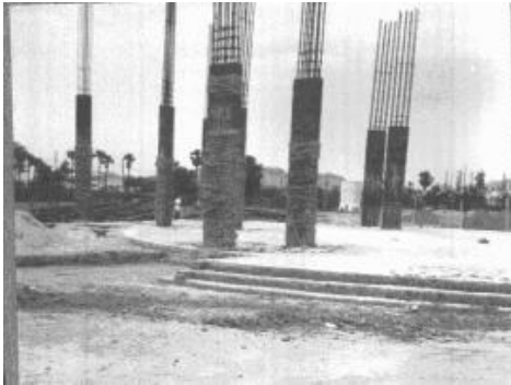
Les premiers piliers, il y a quelques mois
