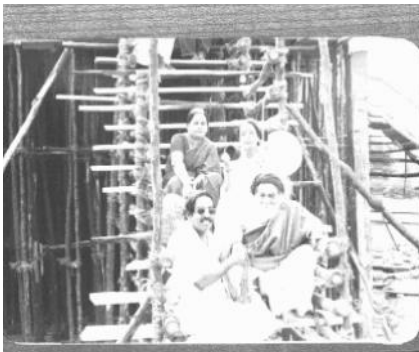
Sur les échaffaudages du mandir circulaire avec Ma Devaki et Mani
